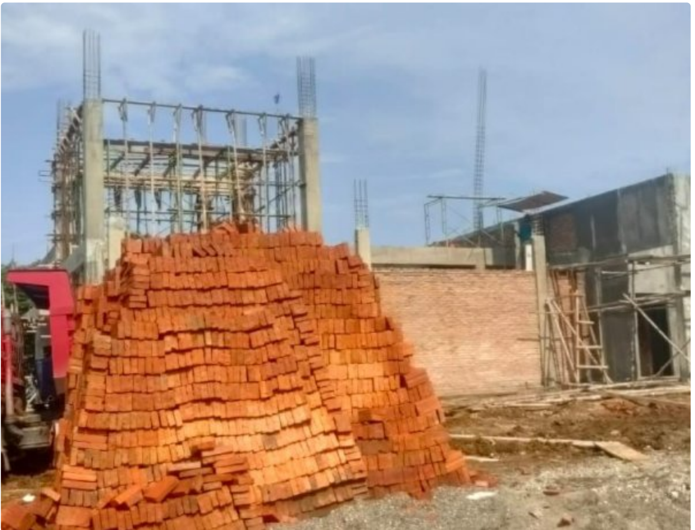
Tampak Pembangunan Kantor Inspektorat Morowali sedang berlangsung
